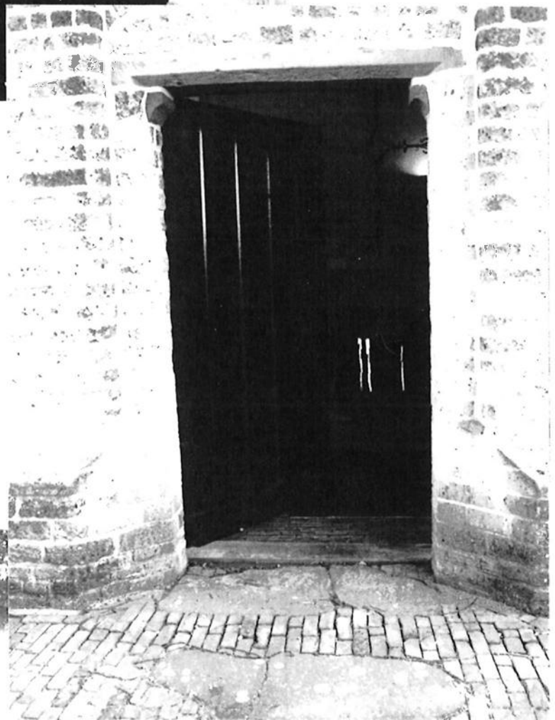
Afb. 8. (Rechts). De westelijke deuropening in de toren, met stenen en dergelijke er omheen, dichterbij. Foto d 7554, za 8-9-2012.
