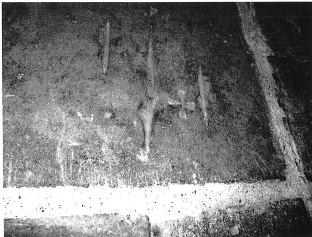
Afb. 13. Wijdingskruisje en slijpsporen in de rechteronderhoek (= de huidige zuidwesthoek) van Buurmalsen G. Foto d 6088, za 10-9-2011.
