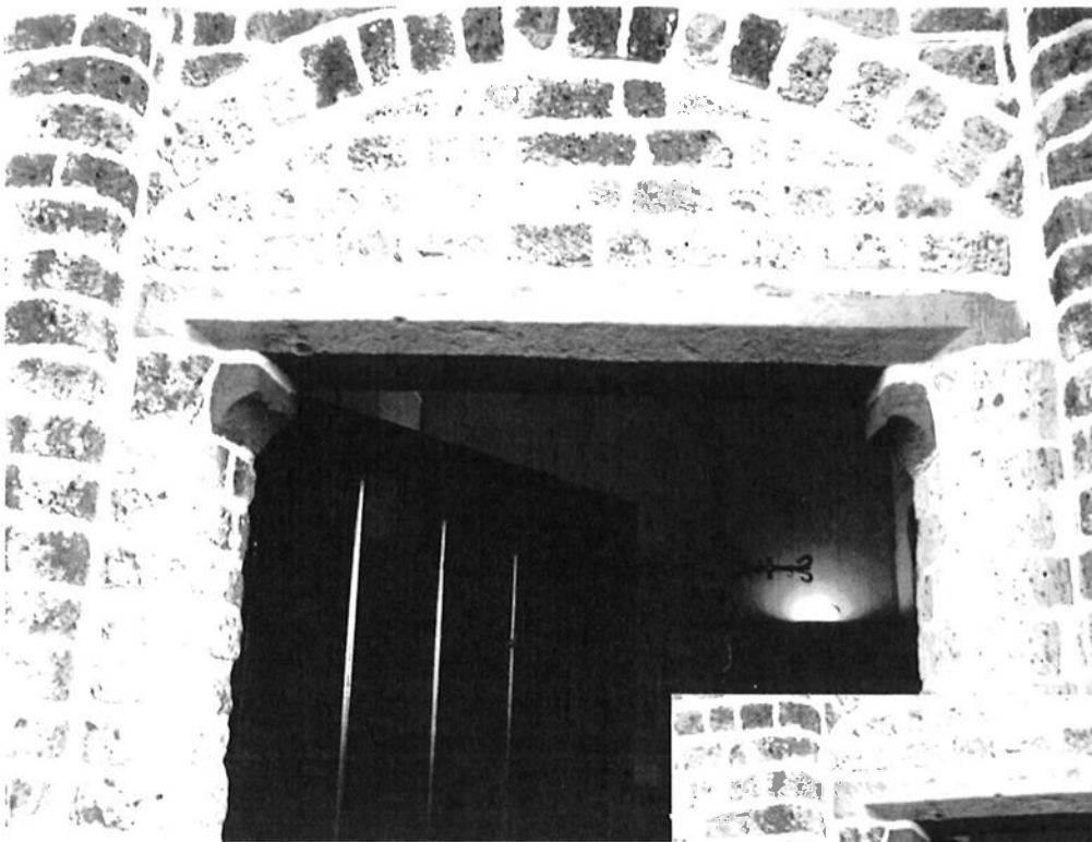
Afb. 7. Links. De (moderne?) plaat rode (bont)zandsteen boven de westelijke toreningang. Foto d 7553, za 8-9-2012.
