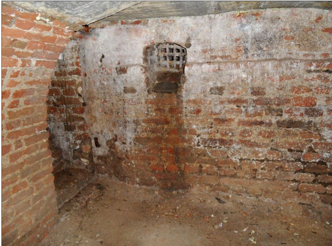
De ruimte onder de vloer van de toren van Beesd. (Foto auteur)
