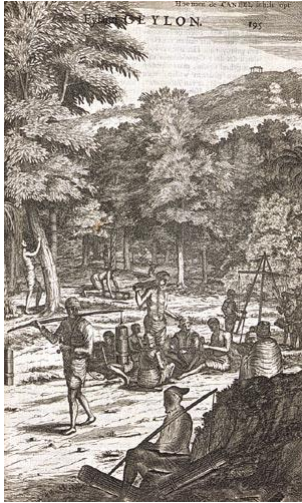
kaneelchillers aan het werk
